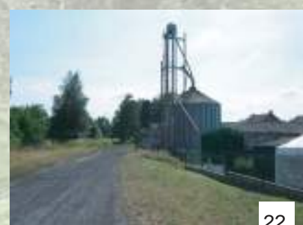
Batiment industriel à proximité du chemin
