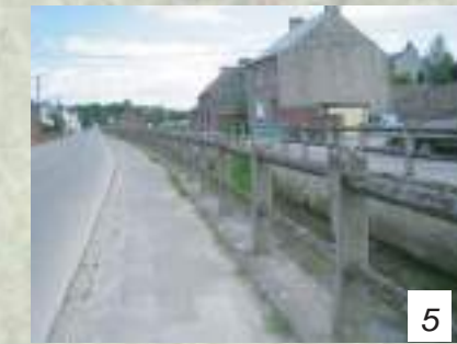
Les abords de la nationale sont équipés d'un trottoir d'une largeur de l'ordre d'1,5 mètre.
