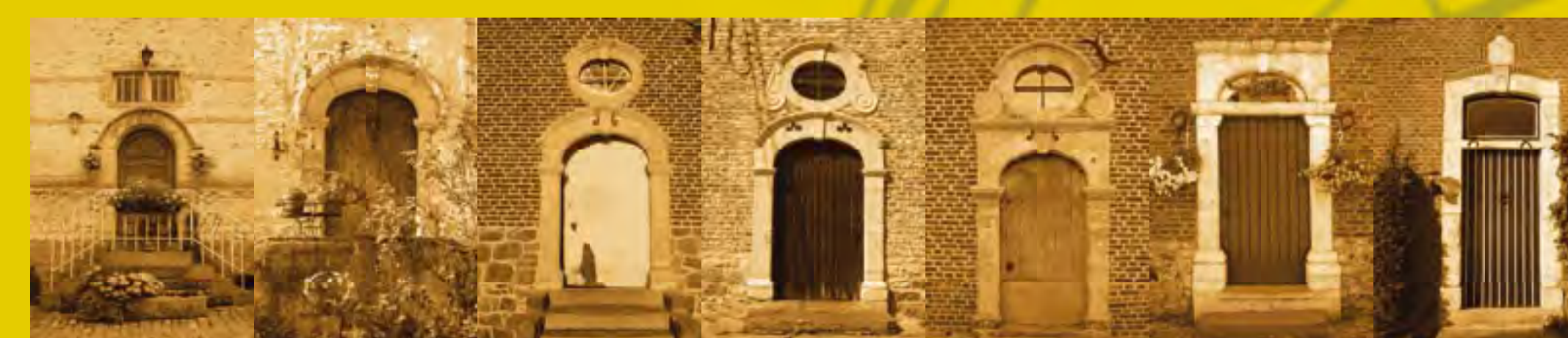
Évolution théorique du tour de porte en pierre de Gobertange, du milieu du XVII e s. à la fin du XVIII e s. : ferme de la Tilleraie à Bonal (mi XVII e s.), ferme du Grand Haquedou à Roux-Miroir (vers 1660), ferme de Sery à Orlon (vers 1717), ferme Saint-Jean l'Évangéliste à Petit-Rosière (vers 1730), ferme à Mont-Saint-André (1753), ferme à Pâtreaux (1771), ferme à Noddinge (1780).
