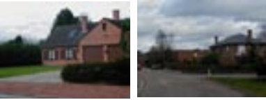
Les bâtiments et leurs abords - 15 - RCU Beauvechain - Octobre 2005
