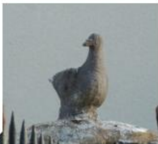
Amortissement de mur
